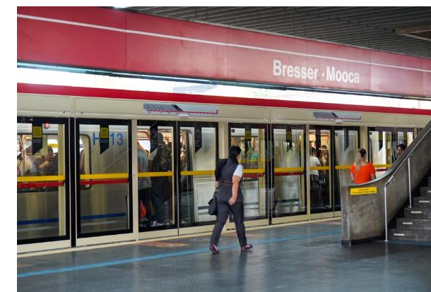
PORTAS DE PLATAFORMA DA ESTAÇÃO BRESSER-MOOCA
