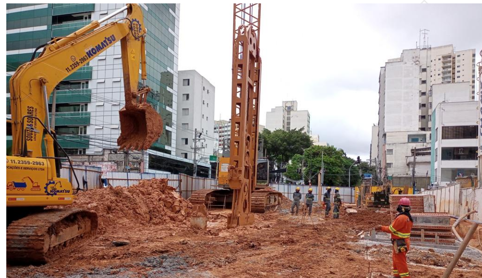
Mezanino de Integração com Linha 6 – Laranja Execução das contenções - Paredes Diafragma
