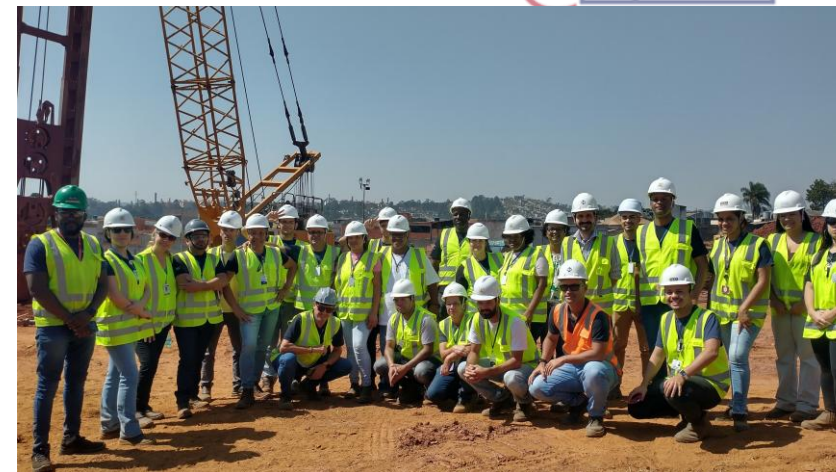
Visita às obras de expansão da Linha 15-Prata com estudantes do SENAC em 2024.
