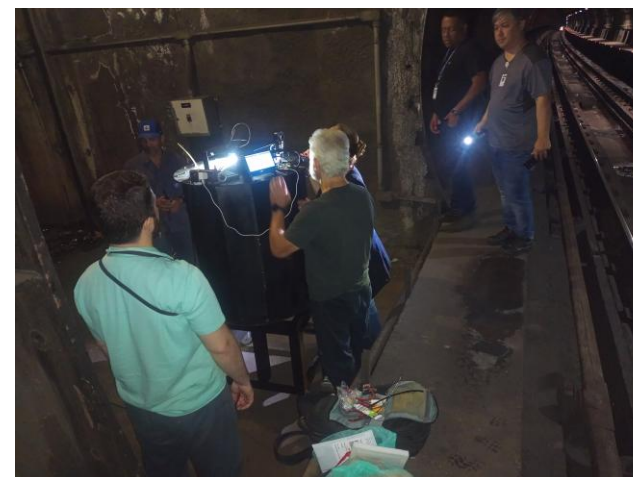
Pesquisadores do ITA e engenheiros do Metrô instalando a turbina na madrugada para realização de Prova de Conceito.
