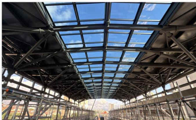
Cobertura Estação Washington Luís
